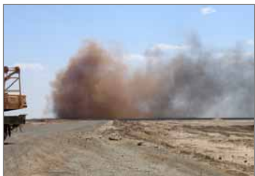
Аварийный сброс газа в окр. газокomppressorной станции Тулей. Фото А.Есипова
